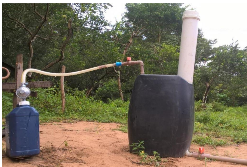
Figura 1 – Biodigestor construído, com todas as partes devidamente montadas.
