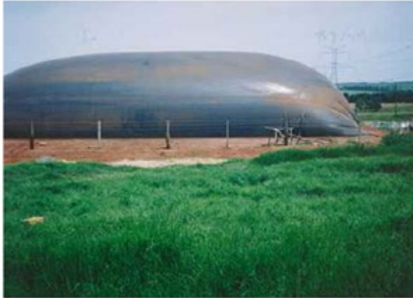
Figura - 3 Biodigestor modelo canadense
