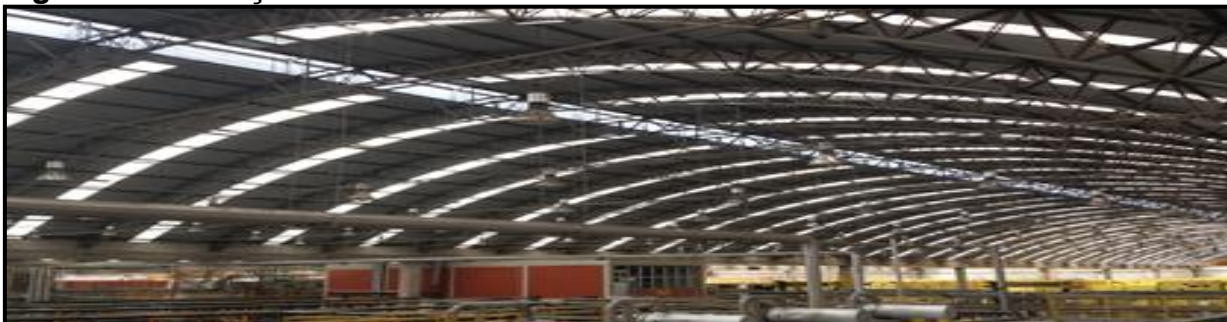
Figura 2: Instalação de telhas translúcidas
