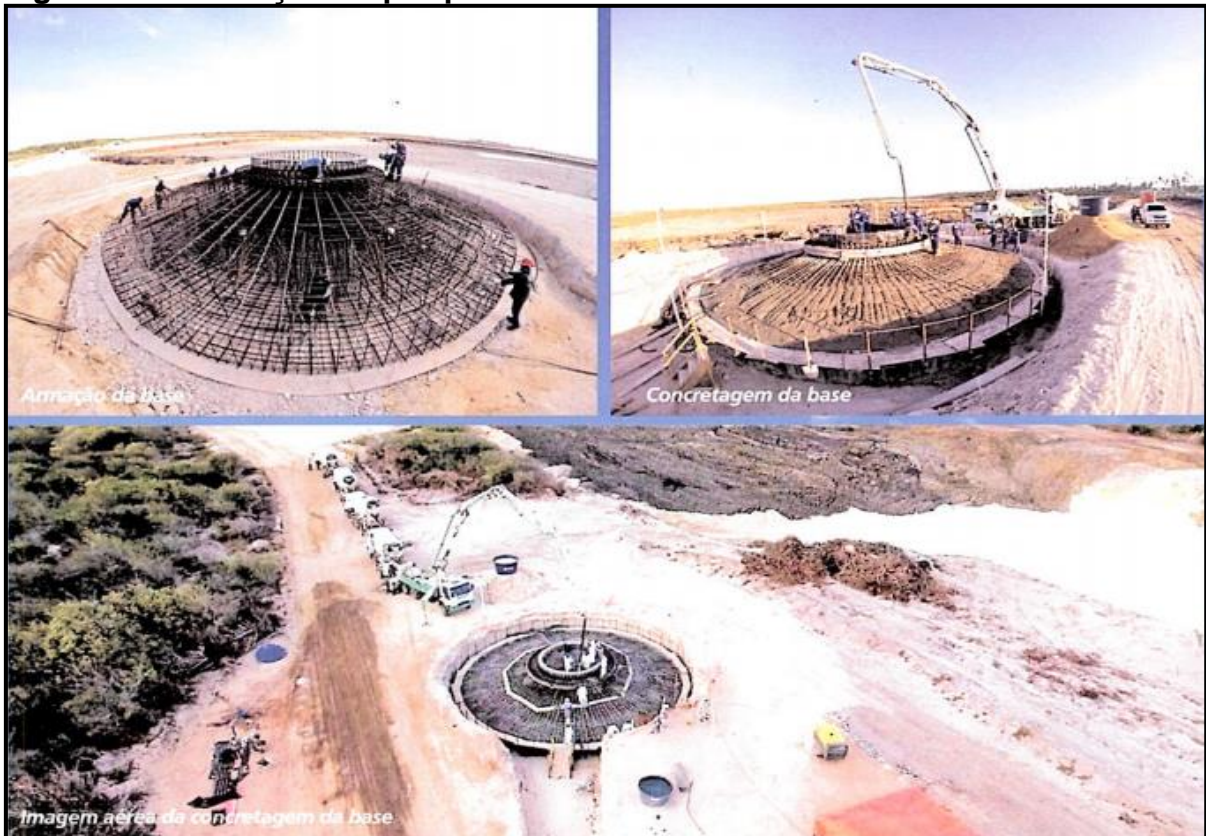
Figura 6: Construção do parque eólico
