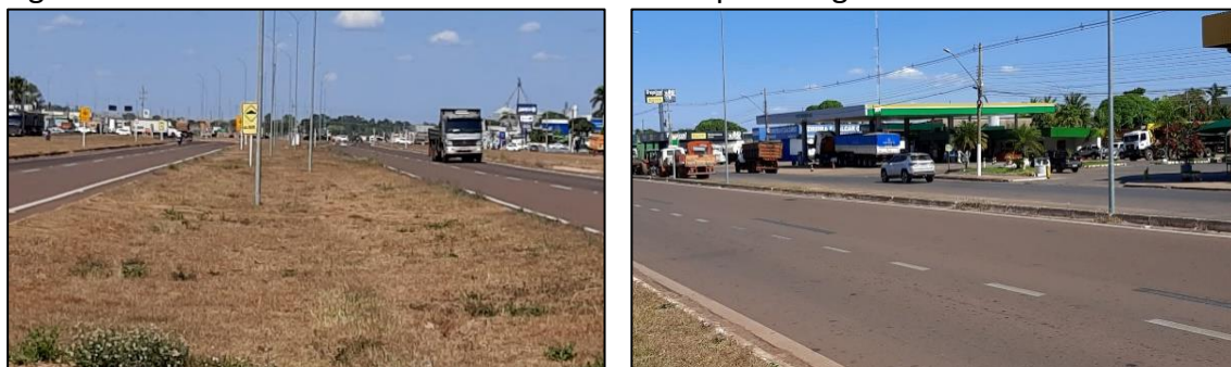
Figuras 3 e 4 - Trecho Urbano da BR 158 no município de Água Boa - MT
