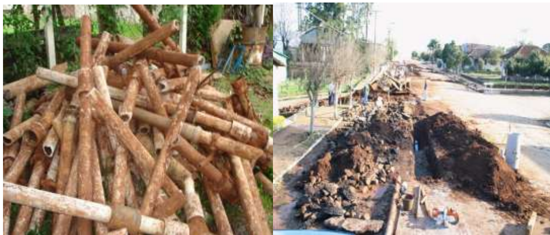
Fotos de substituição de redes
