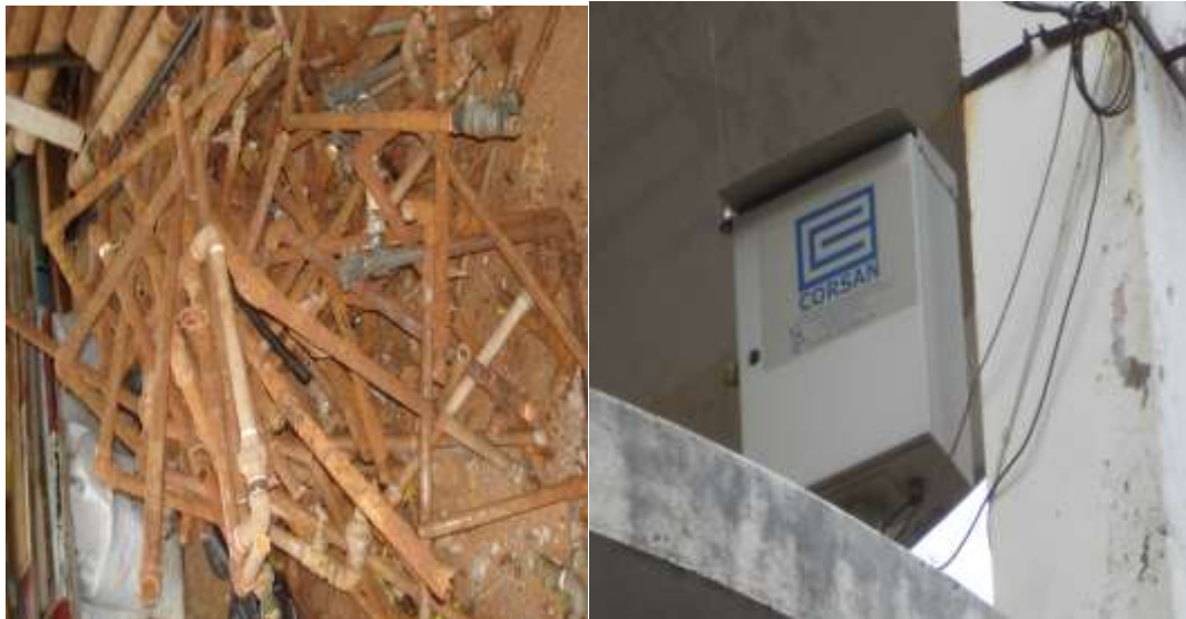
Ramais prediais substituídos e sistema de controle de nível de reservatório
